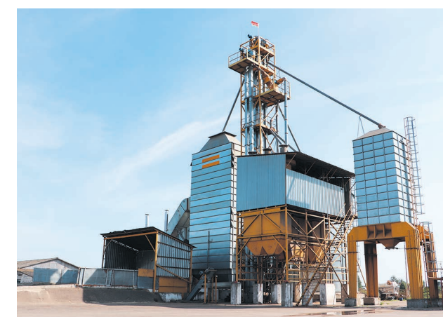
Зерносушильный комплекс в д. Забулье
